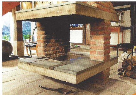
2 Vor dem Umbau nur mit Sicherheitsabstand zu genießen: Das Lagerfeuer im eigenen Wohnzimmer.
